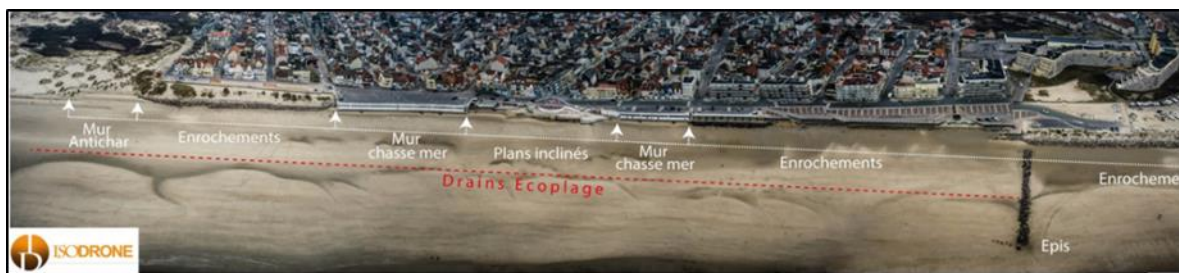
Figure 3. Localisation des ouvrages existants
