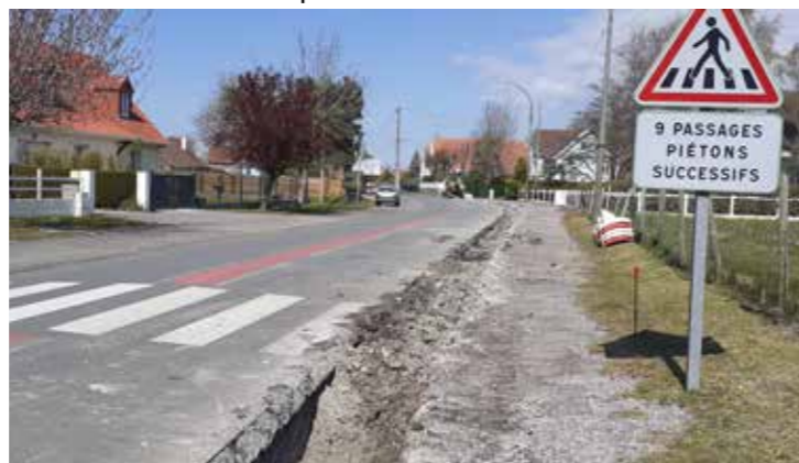
Rang-du-Fliers a bénéficié d'une aide pour la rénovation de plusieurs voiries.
